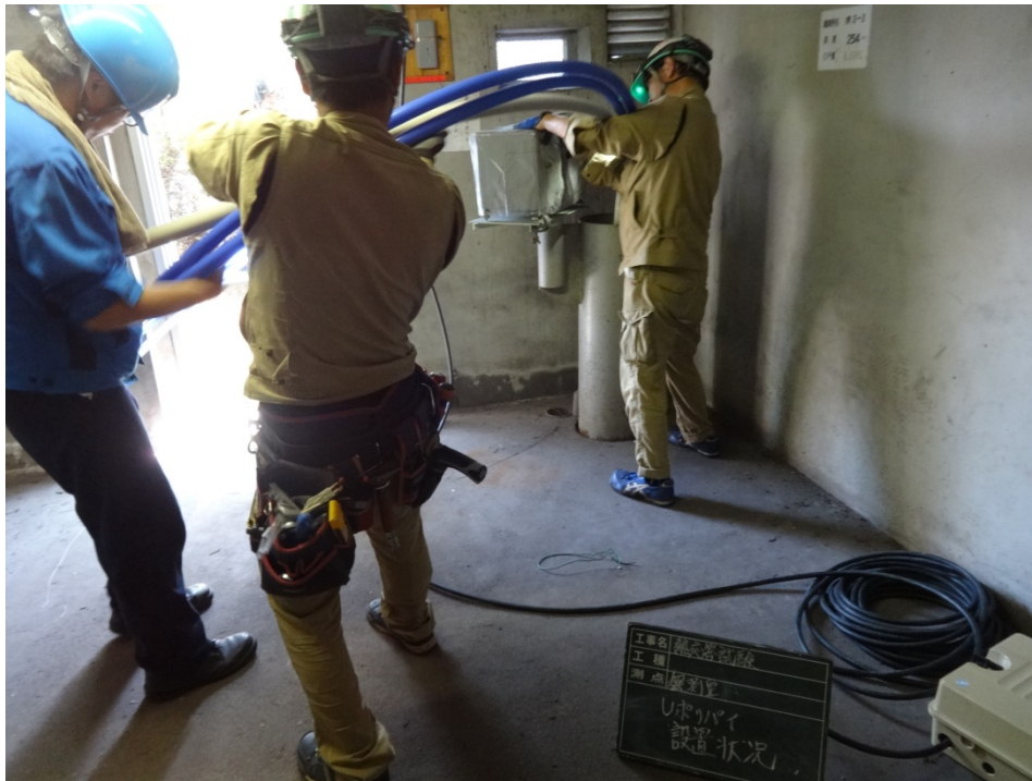
図 13 U ポリパイプ挿入状況
