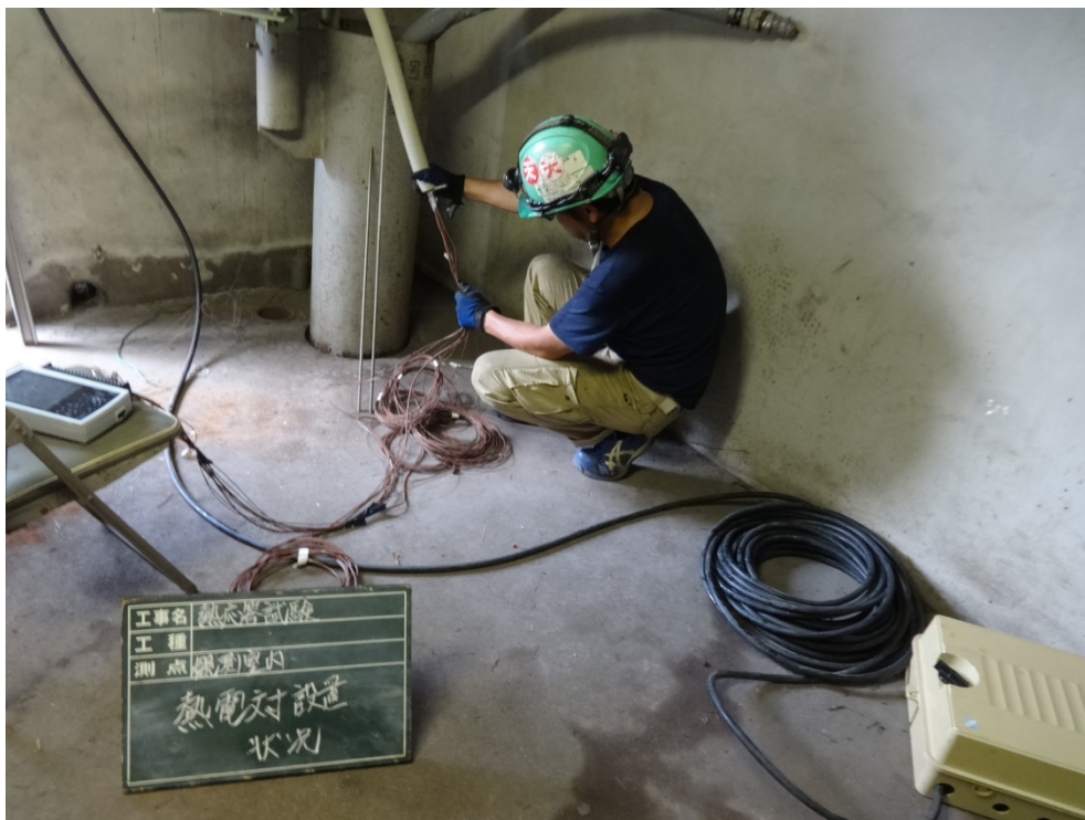
図 14 熱電対設置状況
