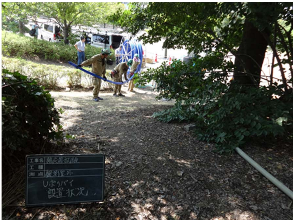
図 12 U ポリパイプ引き込み状況
