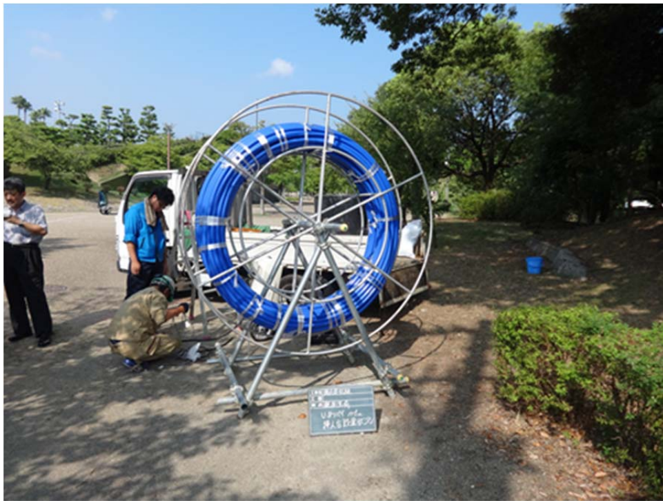
図 11 U ポリパイプ挿入台設置状況
