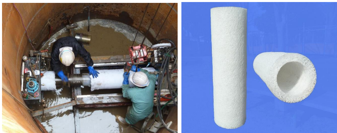
写真-1 推進工法の状況とドレーン管
