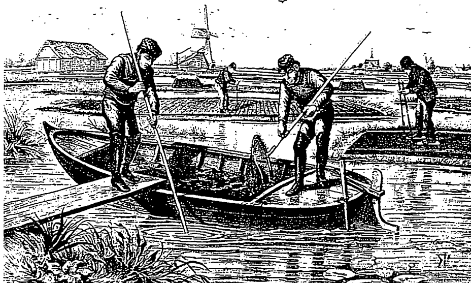
図8 ハンドドラッグを用いた水面下の泥炭掘削風景 6)
