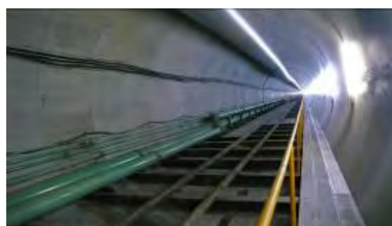
写真 3 現在の施工状況
