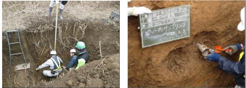
図 - 3 テストピット掘削及びサンプリング状況
