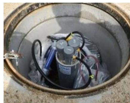
写真—4 完成状況
