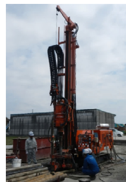
写真-3 掘削状況
