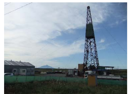
写真1 大深度調査の風景。この櫓を用いたボーリングでは、地表から最大1200m深までの掘削を行い、地質試料や地下水試料を採取した。
